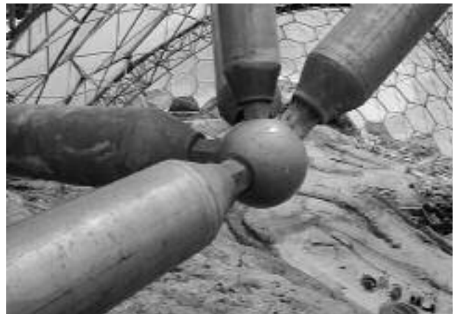
Bild 16. Klassischer MERO-Knoten als Untergurtknoten Fig. 16. Classic MERO node for the bottom nodes
