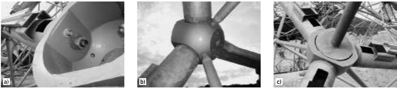
Bild 14. Napfknoten im Obergurt, a) mit den Obergurtrohren, b) den Diagonalen, c) mit dem Pin für die Befestigung eines Zugangssystemes
