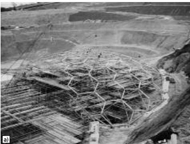
Bild 24. Montage der a) Kuppel A, b) HTB-Kuppeln
