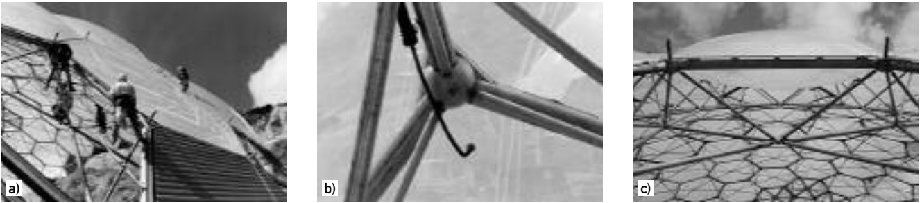
Bild 23. Luftkissen, a) Montage durch Abseilpersonal, b) Anschluß der Luftzufuhr, c) Montage Fig. 23. Cushion; a) Installation by Abseilers, b) air input connection, c) installation
