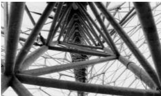
Bild 18. Blick in den Bogenbinder Fig. 18. View of the arch
