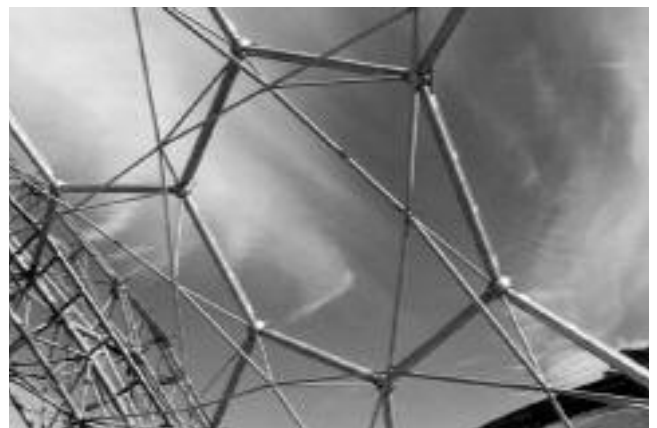
Bild 11. Ansicht der Hex-Tri-Hex-Struktur ; Obergurt – Diagonale – Untergurt Fig. 11. View of the Hex-Tri-Hex structure; top chord – diagonals – bottom chord
