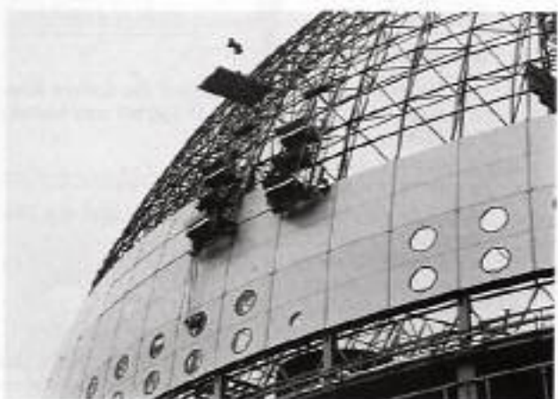
Bild 15. Montage einer Verbundplatte mit einem fahrbaren zweiteiligen Hilfsgerüst. Einheiten der Platte in horizontaler Lage durch Turmdrehkran
