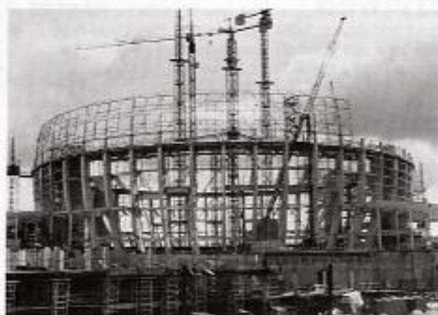
Bild 12. Montage der vormontierten Einheiten mit Autokran vom Inneren der Arena
